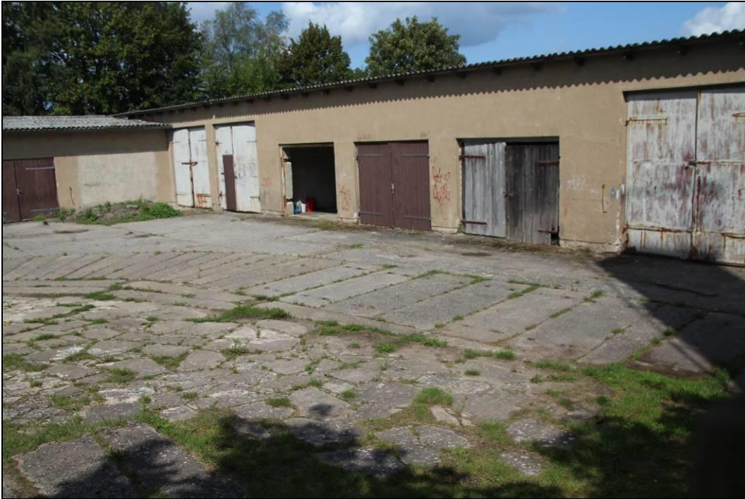
Abbildung 11: noch teilweise genutzte Halle des Gebäudekomplexes 2
