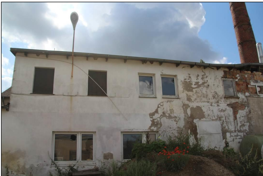
Abbildung 29: nicht mehr genutzte Mehlschwalbennester an der Ostfassade des Gebäudes 1
