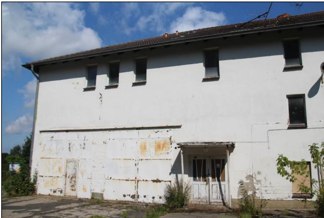
Abbildung 4: Gebäude 1 aus Richtung Süden
