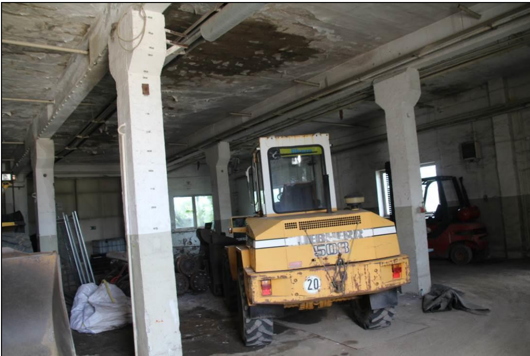
Abbildung 8: noch als Garagen genutzte Räume im Erdgeschoss des Gebäudes 1
