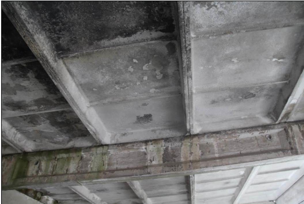
Abbildung 23: potenziell als Sommerquartier für Zwergfledermäuse geeignetes Dach aus Betonteilen im Norden des Gebäudekomplexes 1
