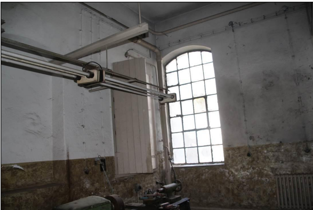
Abbildung 6: Innenansicht des Gebäudes 1. Im Erdgeschoss befand sich eine Werkstatt.
