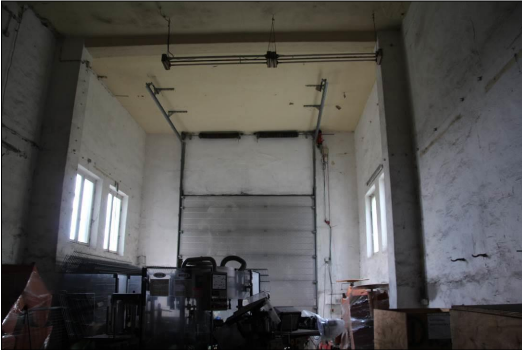
Abbildung 5: als Lager genutzte Räume im Erdgeschoss des Gebäudes 1
