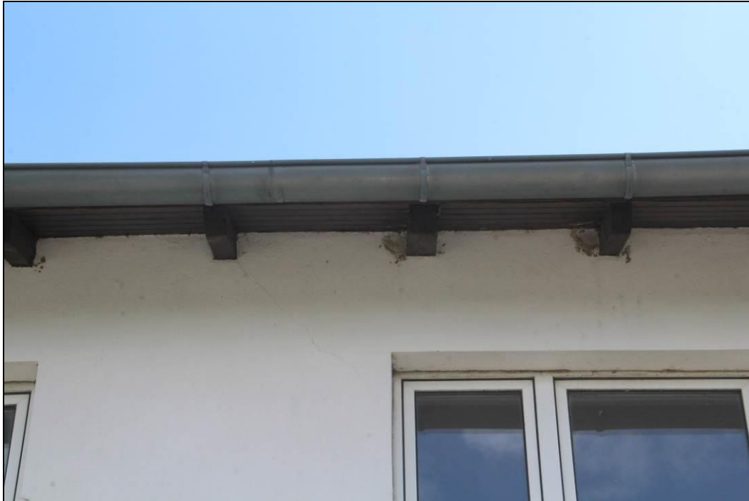
Abbildung 28: alte, nicht artenschutzrechtlich relevante Nester der Mehlschwalbe am Gebäude 1
