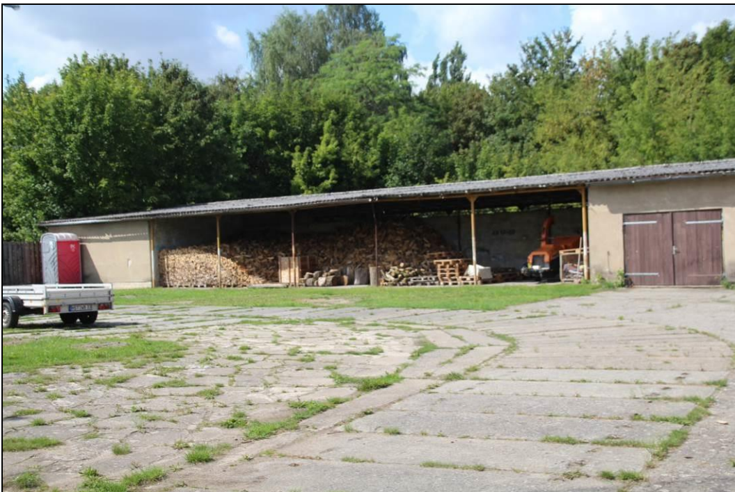
Abbildung 10: noch teilweise genutzte Halle des Gebäudekomplexes 2
