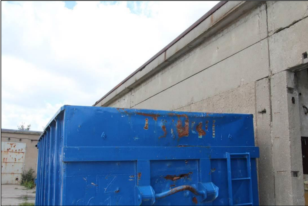
Abbildung 9: mit Betonelementen gedeckte Halle im nördlichen Teil des Gebäudekomplexes 1
