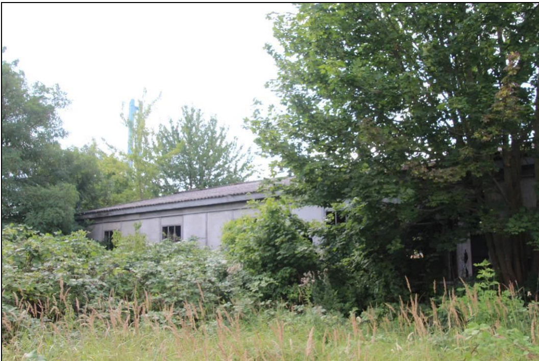
Abbildung 14: fast vollständig von Armenischer Brombeere umwucherte Halle des Gebäudekomplexes 2
