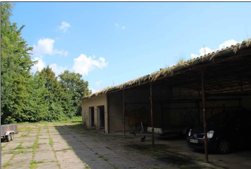
Abbildung 12: noch teilweise genutzte Halle des Gebäudekomplexes 2
